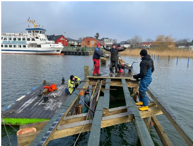
Stegbau im Winterhalbjahr
